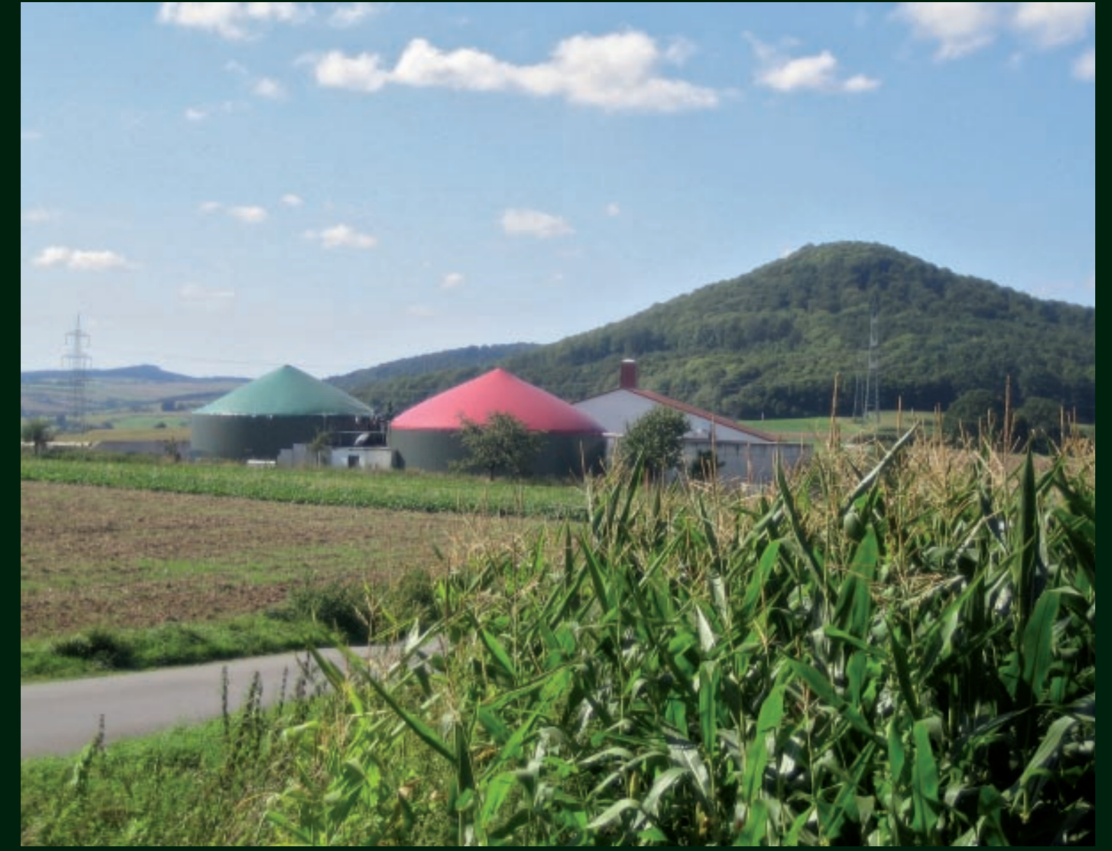
Biogasanlage bei Hofgeismar-Schöneberg
