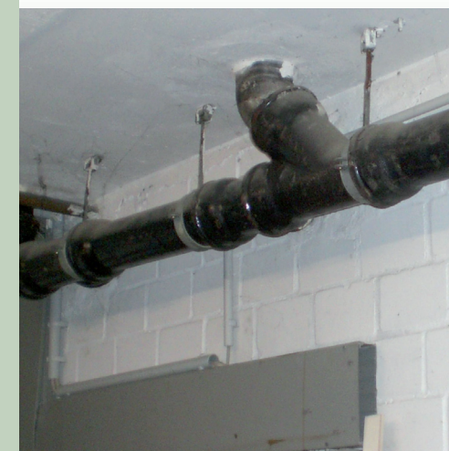
Abhängen der Leitungen unter der Kellerdecke
