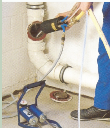
Inspektion durch Revisionsöffnung
